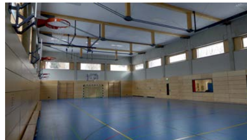
Innenansicht Halle mit unterspannte Bindern
